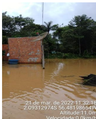
Figura 4. Alagamento no bairro Conquista. (Fonte: Defesa Civil, Terra Santa).
